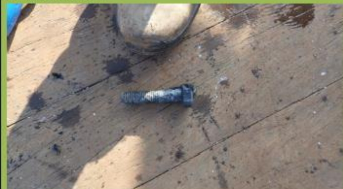
Omschrijving: Bout M16 aangetroffen
